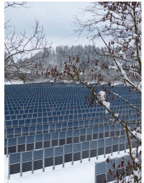
Bifaziale Agri-Fotovoltaikanlage in Donaueschingen-Aasen im Winter Fotografiert von Herrn Dr. Karl Müller-Sämann
