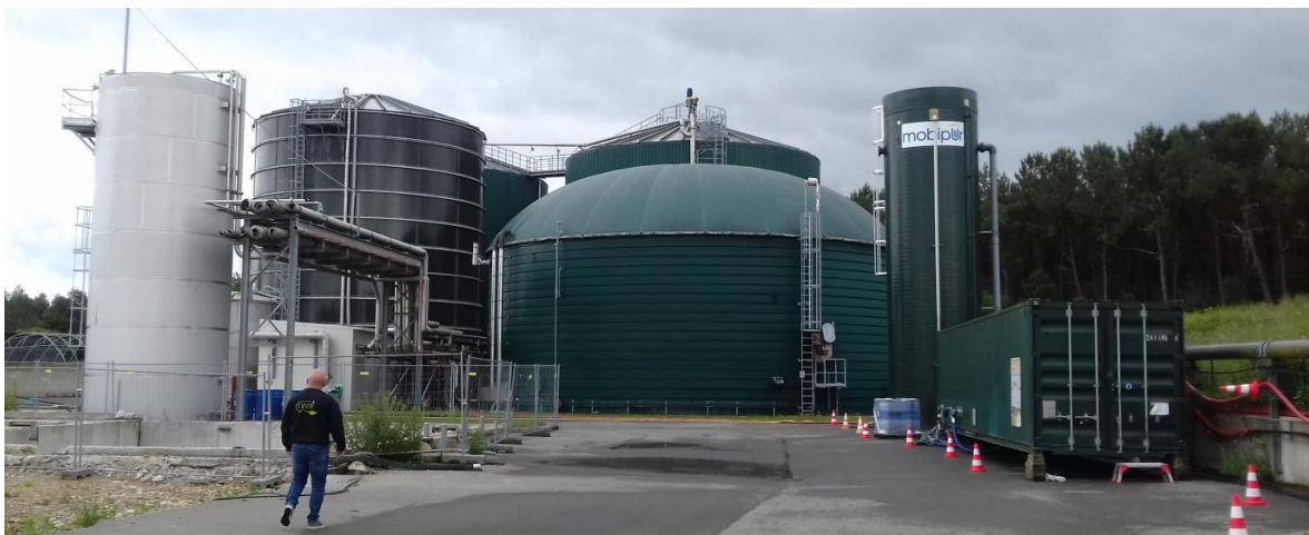
Abbildung 26: Die Géotexia Methanisierungsanlage in Le Mené. Lehec 2021.
