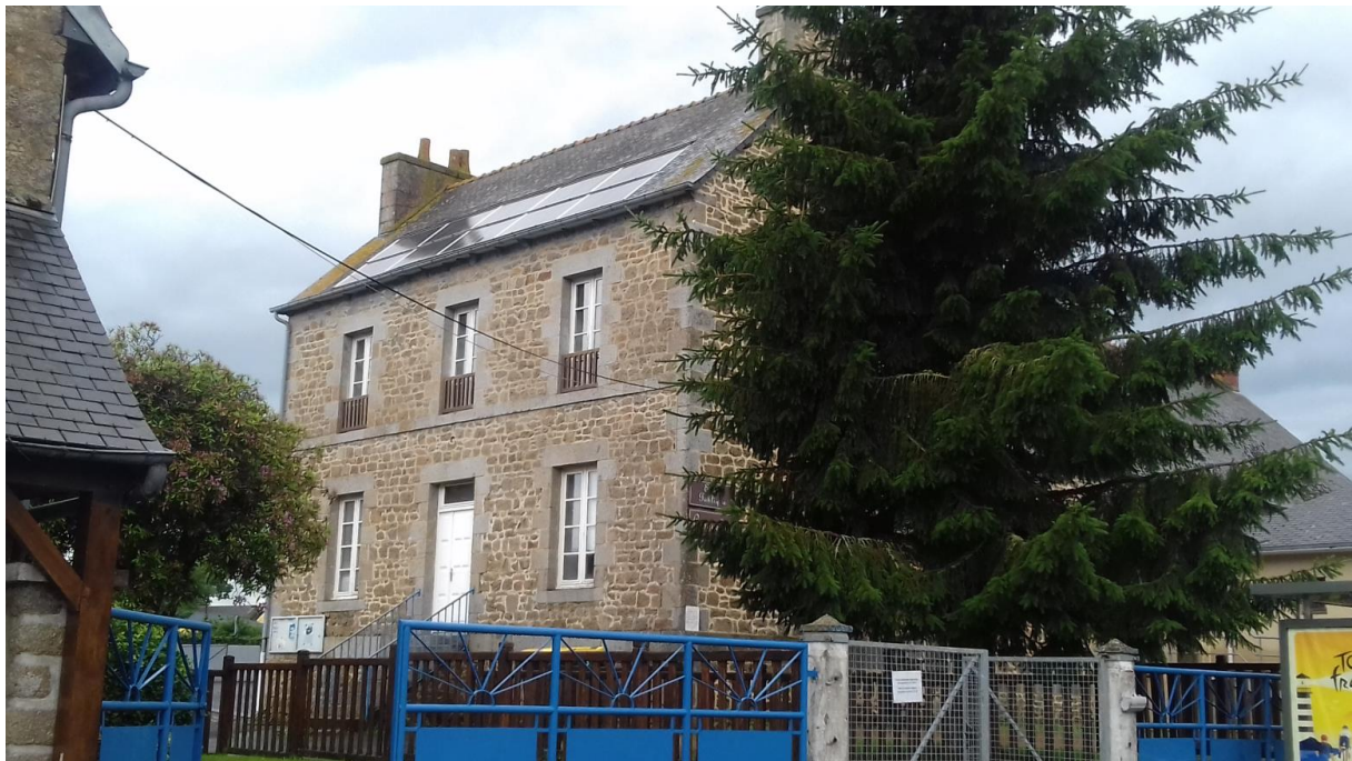
Abbildung 31: Solaranlage auf dem Dach des Rathauses von Le Gouray. Lehec 2021.
