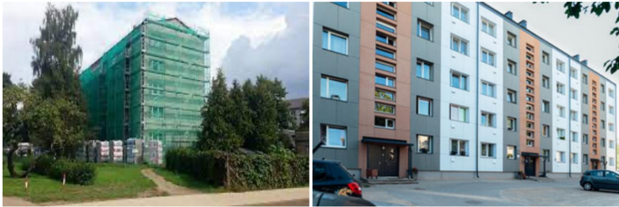
Abbildung 68: Das Gebäude während der Sanierungsphase (links), Gebäudefassade nach der Umsetzung (rechts). Lauris Gruntmanis, o.D..
