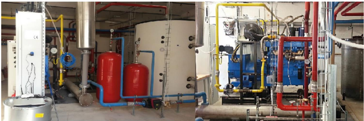
Abbildung 20: Blockheizkraftwerk. EIC 2022.
