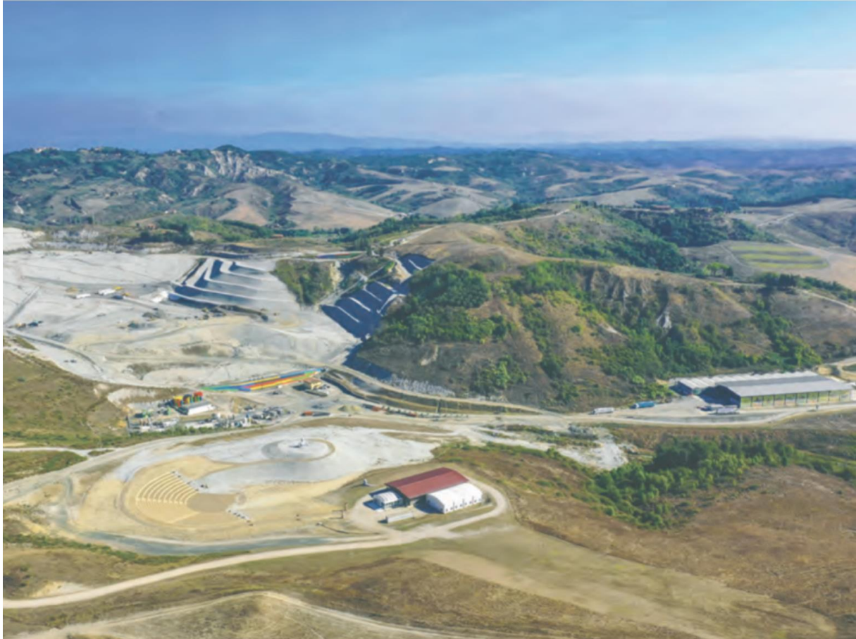
Abbildung 59: Luftaufnahme der Müllsammel- und Energieerzeugungsanlage in der Gemeinde Peccioli, in der Nähe des Ortsteils Legoli. Belvedere SpA 2019.
