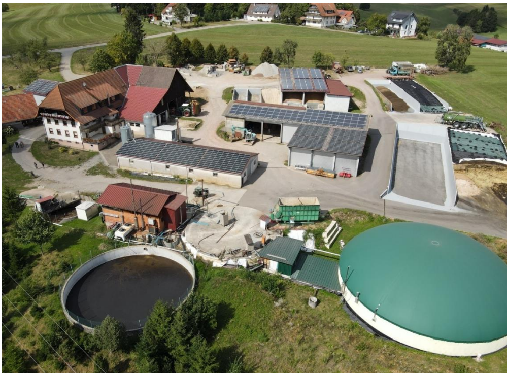
Abbildung 45: Biogas-Anlage des Reinbold-Hofes. Innovation Academy.
