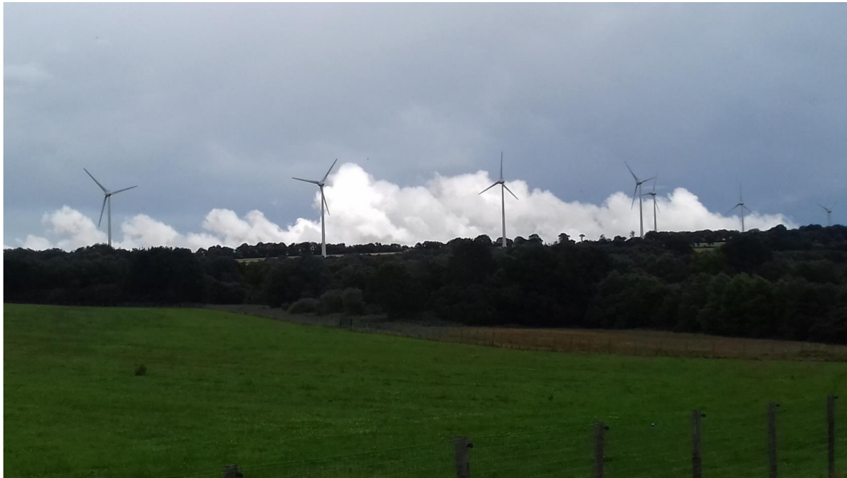
Abbildung 28: Der Windpark Landes du Mené. Lehec 2021.
