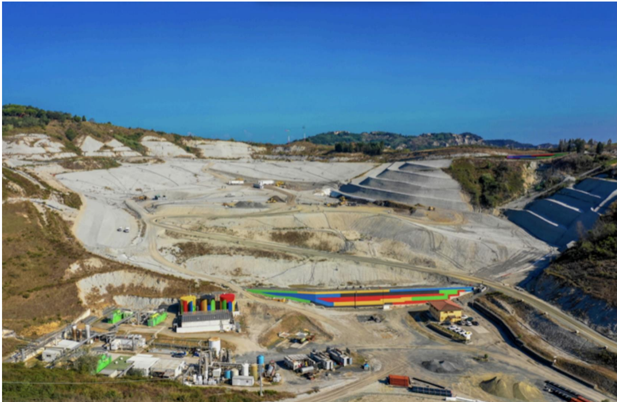
Abbildung 61: Die Abfallsammel- und -behandlungsanlage. Belvedere SpA 2018.
